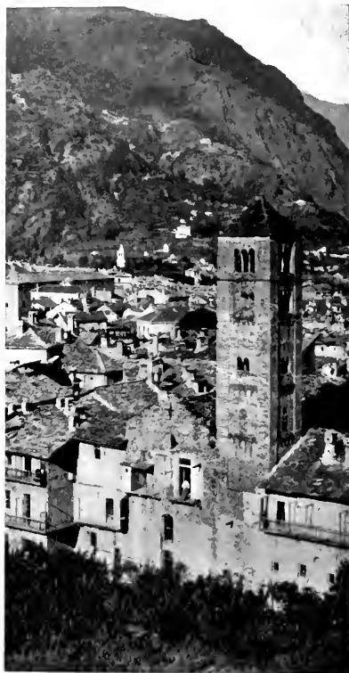
Fig. 44 - Facciata e campanile della chiesa di Santa Maria a Susa (a. 1026)
